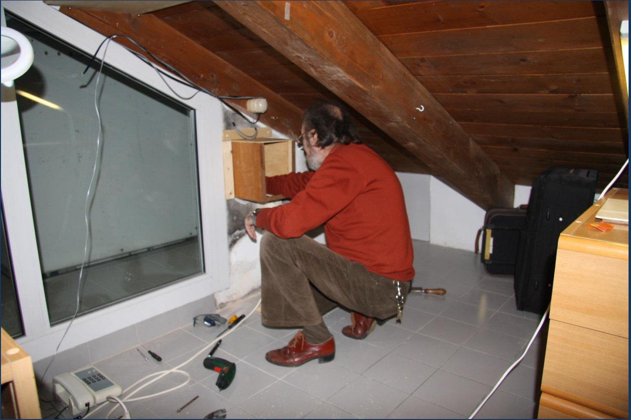
Giorgio installa un'adeguata scatola per la connessione.
