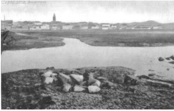
Terreni impaludati ridosso della strada di Sottoriva
